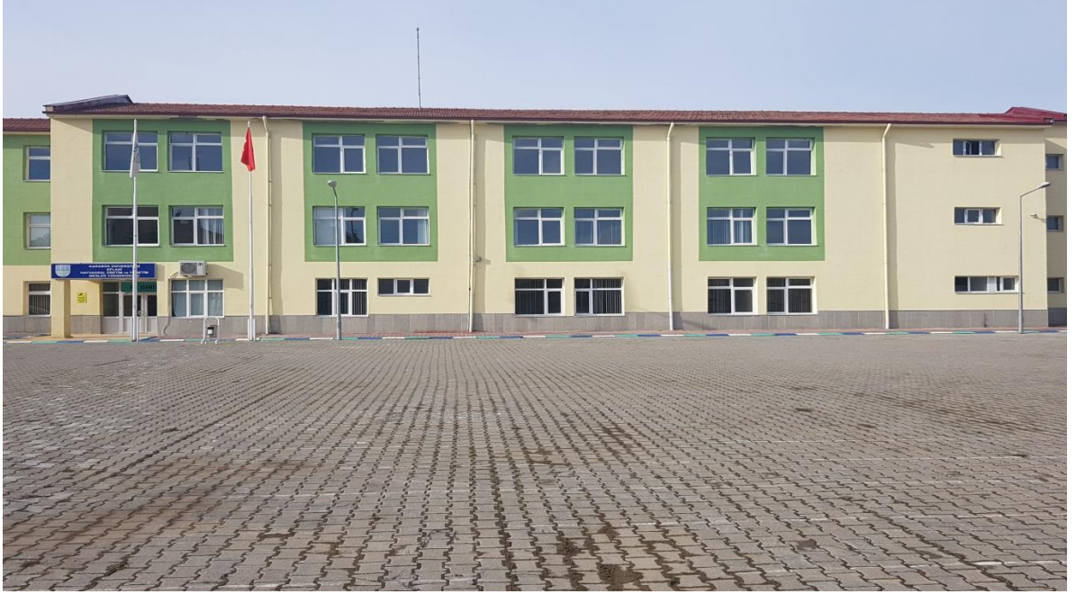
Resim 10. Eflani Meslek Yüksekokulu Binası
