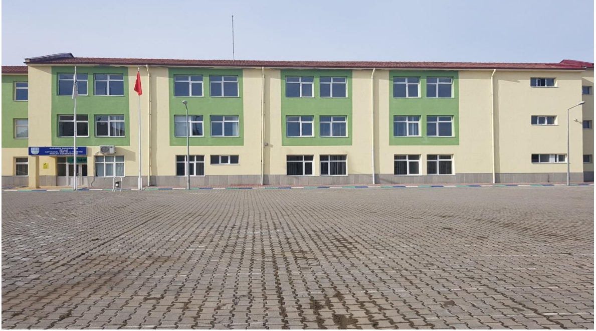
Resim 10. Eflani Meslek Yüksekokulu Binası
