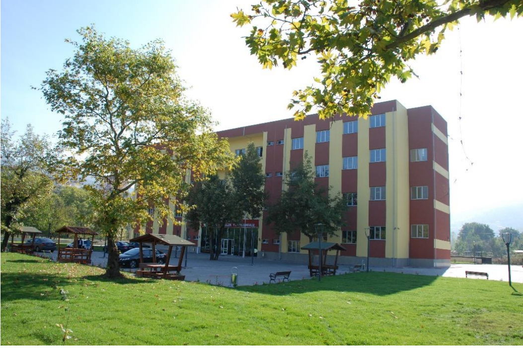
Resim 11. Yenice Meslek Yüksekokulu Binası
