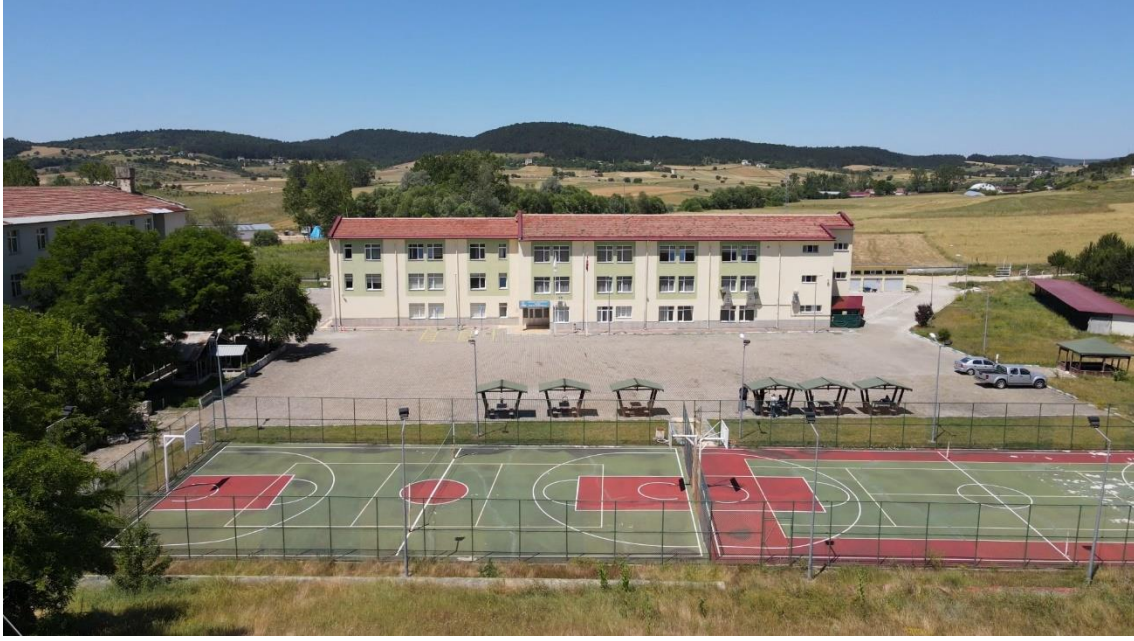
Resim 15. Eflani Meslek Yüksekokulu Binası
