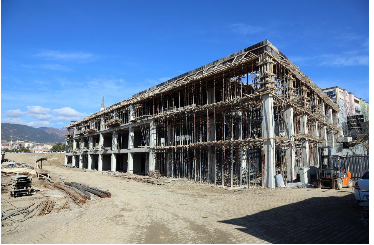
Resim 28. Öğrenci İşleri Merkezi İnşaatı
