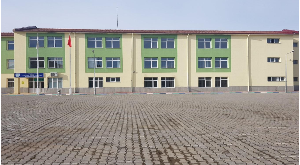
Resim 10. Eflani Meslek Yüksekokulu Binası
