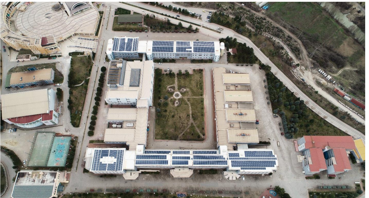
Resim 22. Fotovoltaik Güç Santrali
