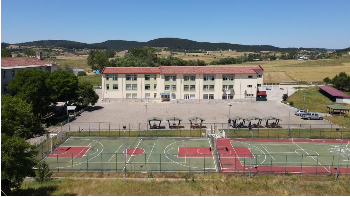
Resim 15. Eflani Meslek Yüksekokulu Binası
