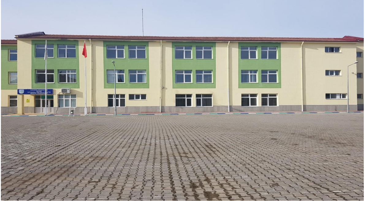
Resim 10. Eflani Meslek Yüksekokulu Binası
