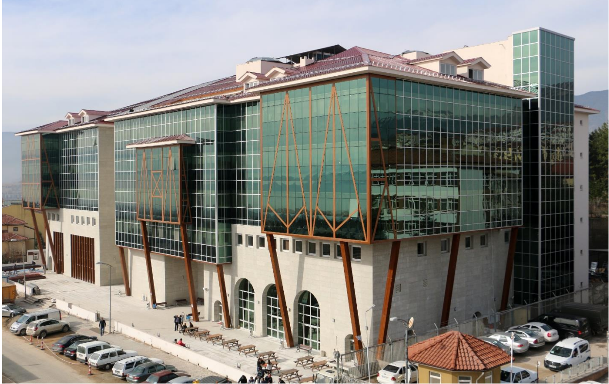
Resim 6. Safranbolu Fethi Toker Güzel Sanatlar ve Tasarım Fakültesi Binası
