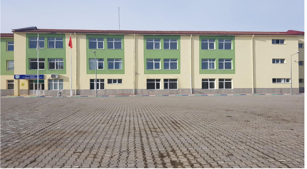
Resim 10. Eflani Meslek Yüksekokulu Binası
