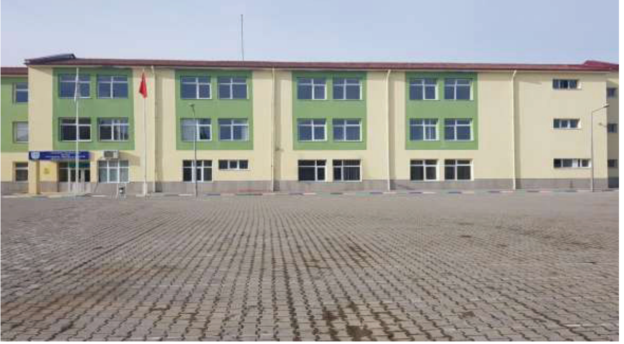
Resim 10. Eflani Meslek Yüksekokulu Binası
