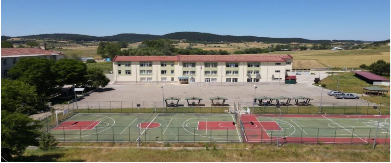
Resim 10. Eflani Meslek Yüksekokulu Binası
