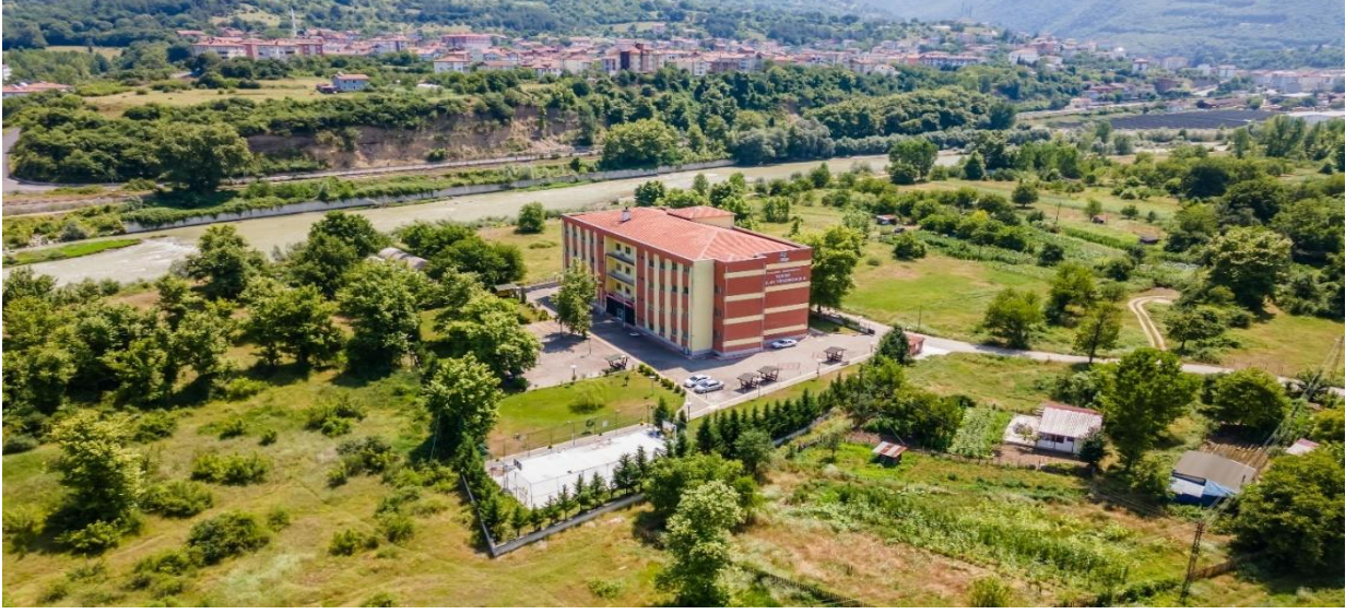
Resim 8. Yenice Meslek Yüksekokulu Binası
