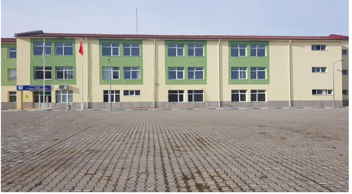
Resim 10. Eflani Meslek Yüksekokulu Binası
