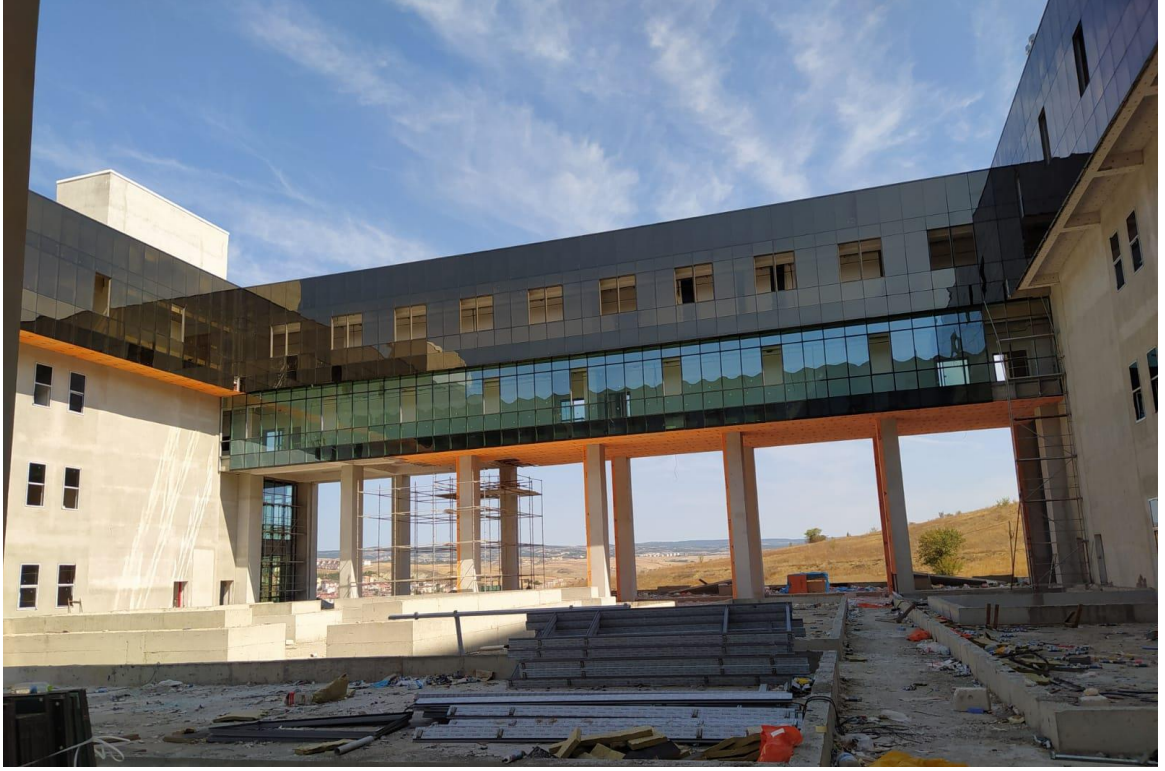
Resim 31. Mühendislik Fakültesi Laboratuvar İnşaatı
