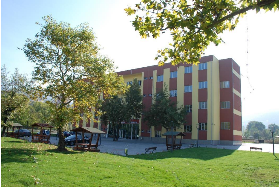
Resim 8. Yenice Meslek Yüksekokulu Binası
