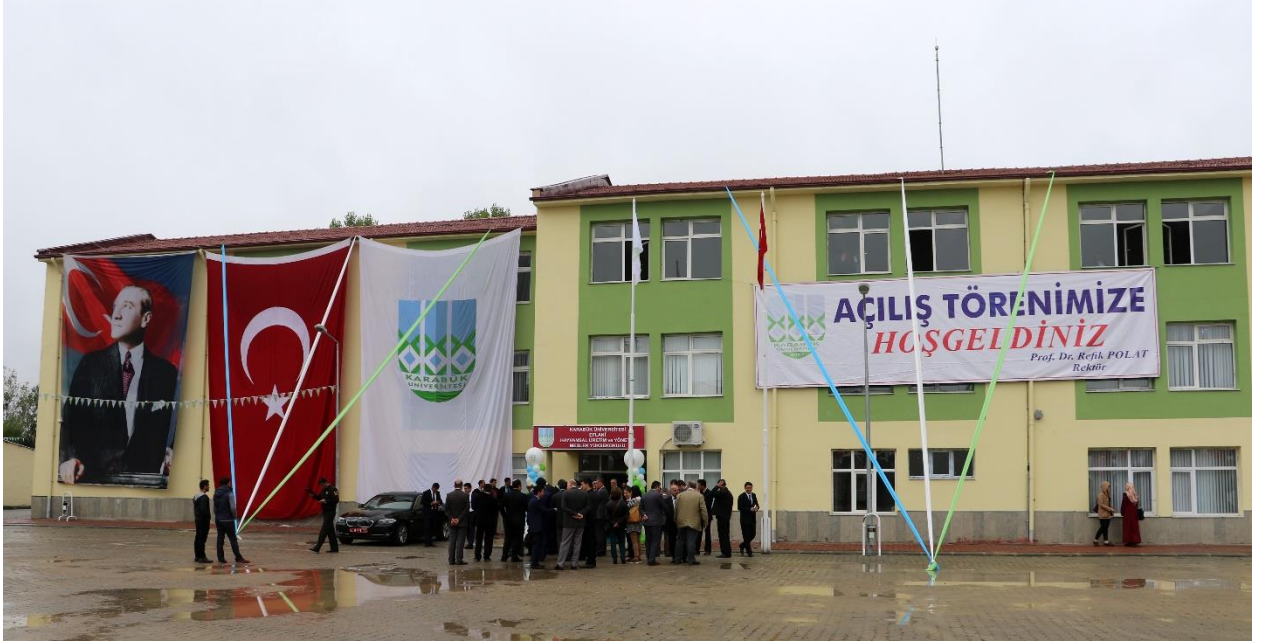
Resim 10. Eflani Meslek Yüksekokulu Binası
