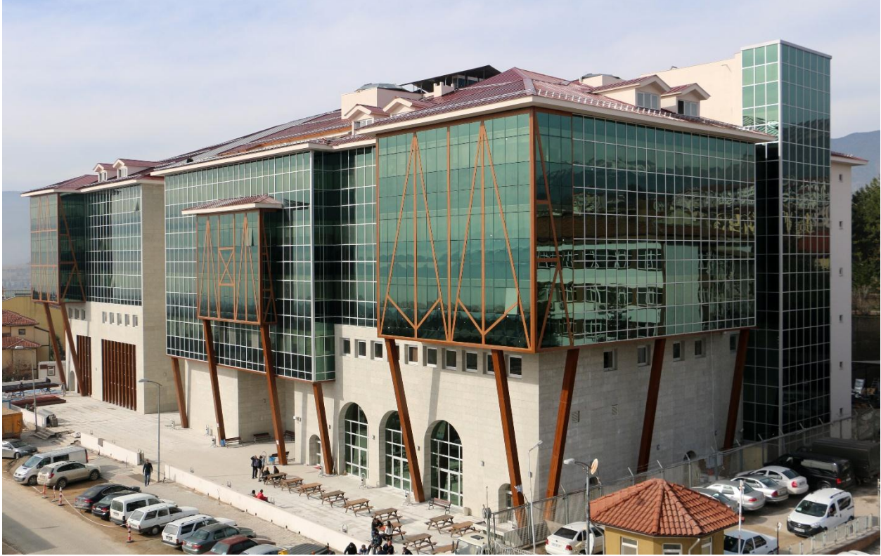
Resim 5. Safranbolu Fethi Toker Güzel Sanatlar ve Tasarım Fakültesi Binası
