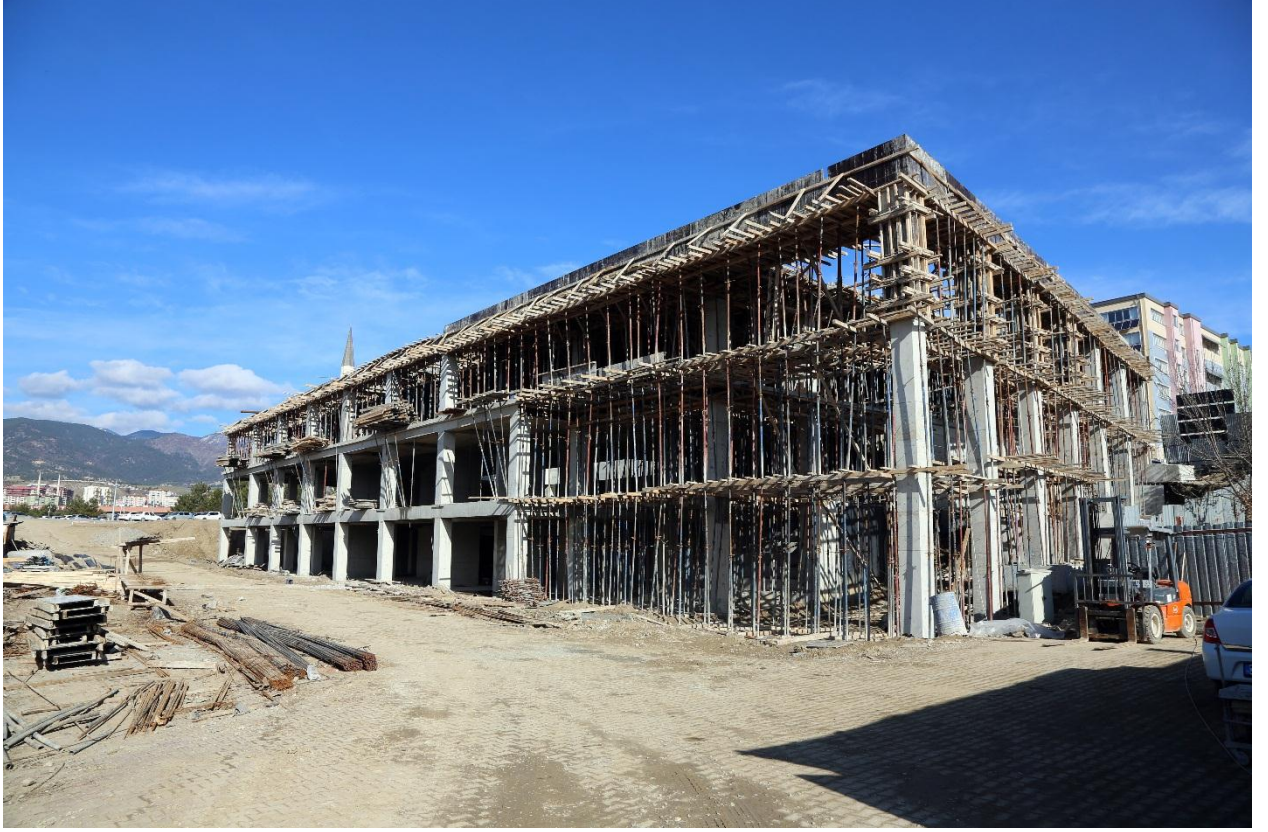
Resim 28. Öğrenci İşleri Merkezi İnşaatı
