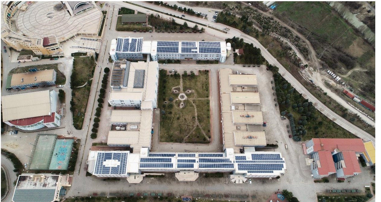
Resim 22. Fotovoltaik Güç Santrali
