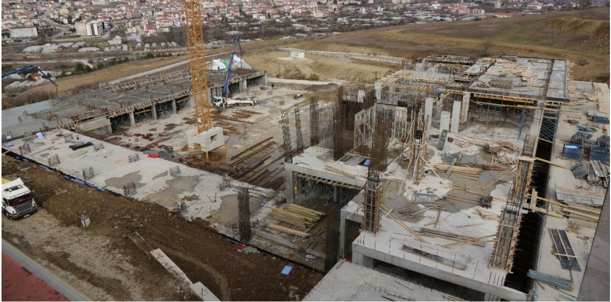
Resim 23. Mühendislik Fakültesi Laboratuvar İnşaatı
