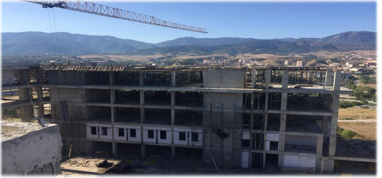
Resim 29. Mühendislik Fakültesi Laboratuvar İnşaatı
