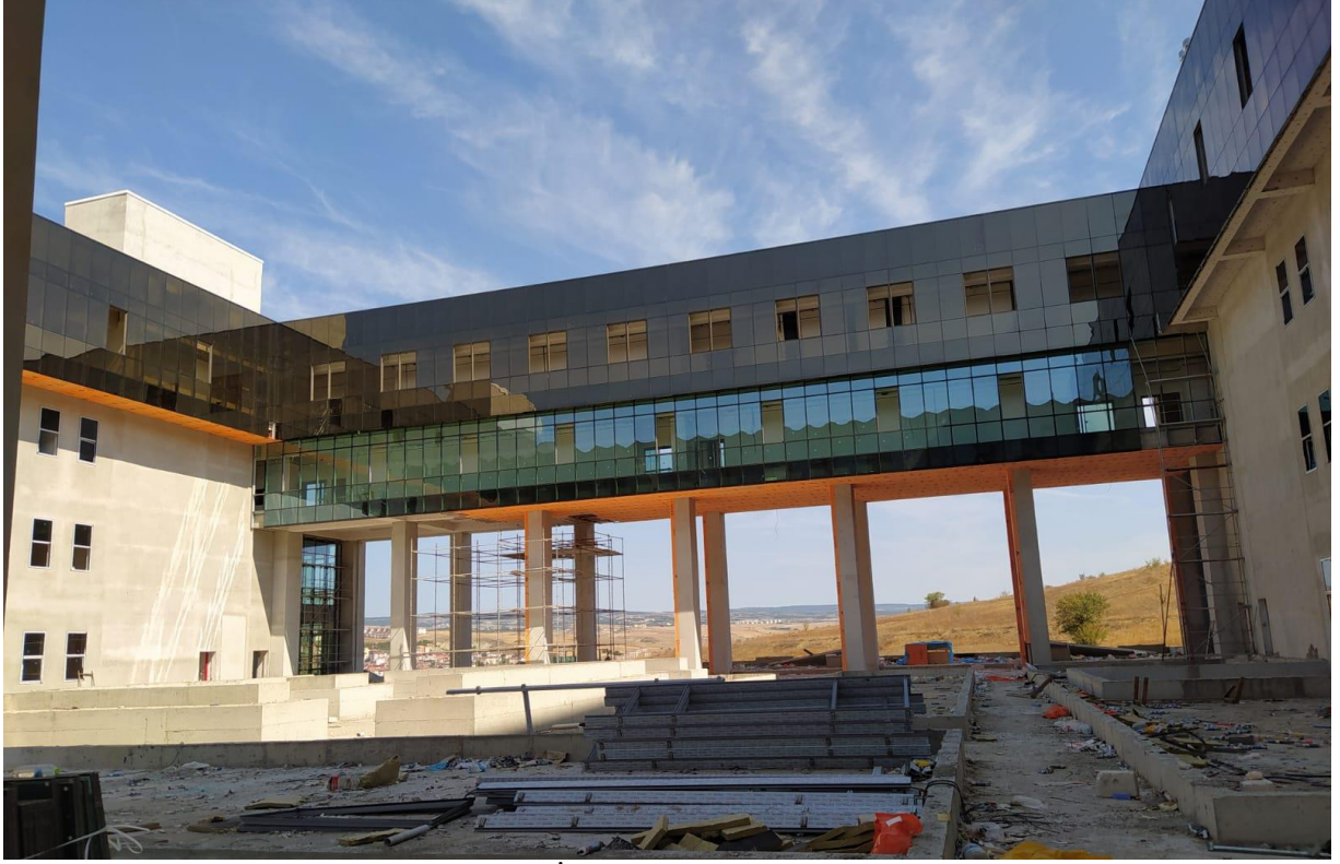
Mühendislik Fakültesi Laboratuvar Binası İnşaatı
